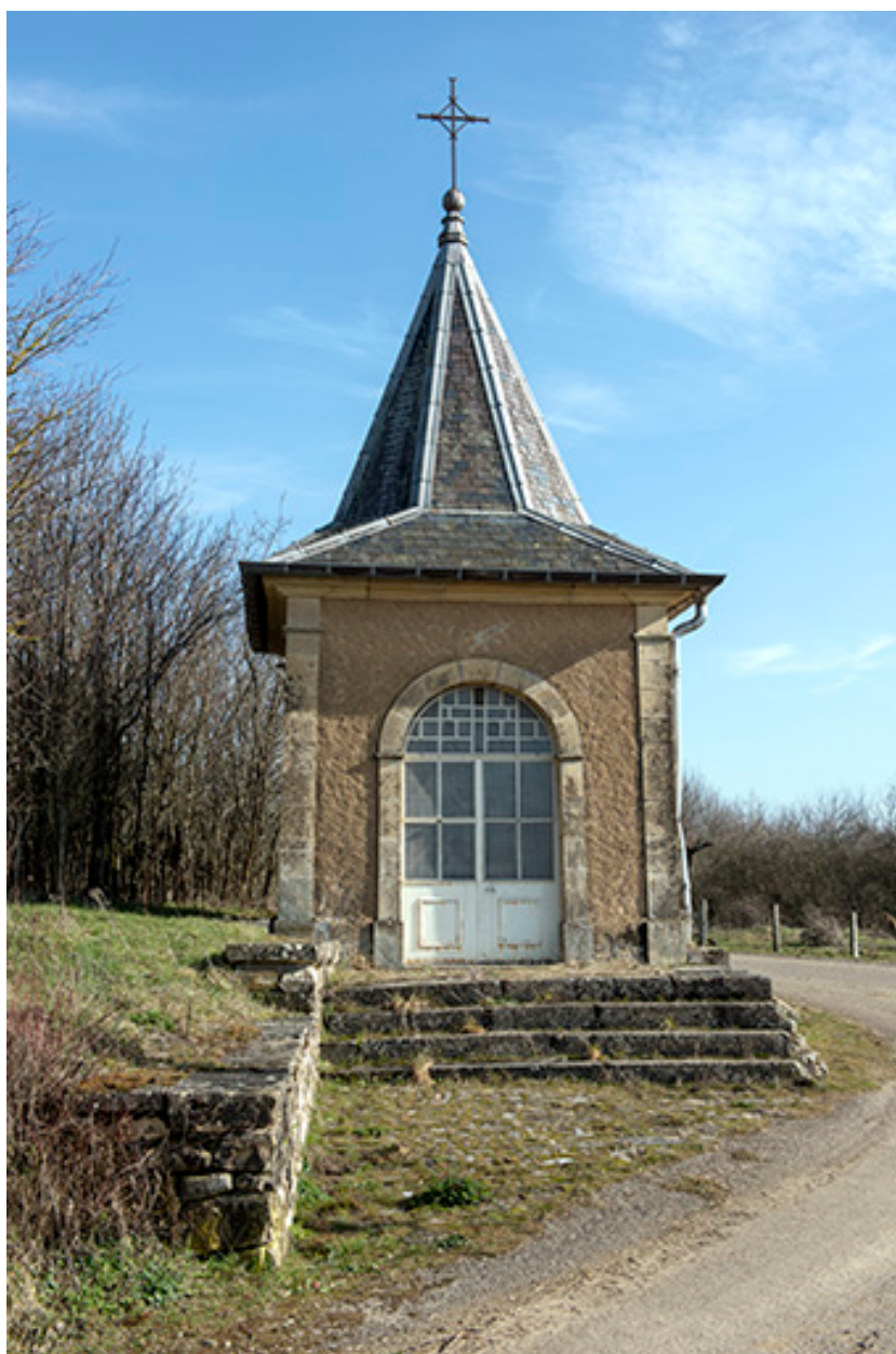
Façade antérieure ouest.
