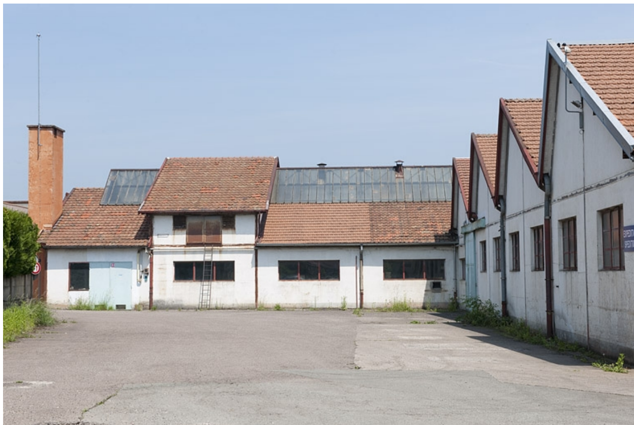
Façade et pignons d'ateliers de fabrication.
