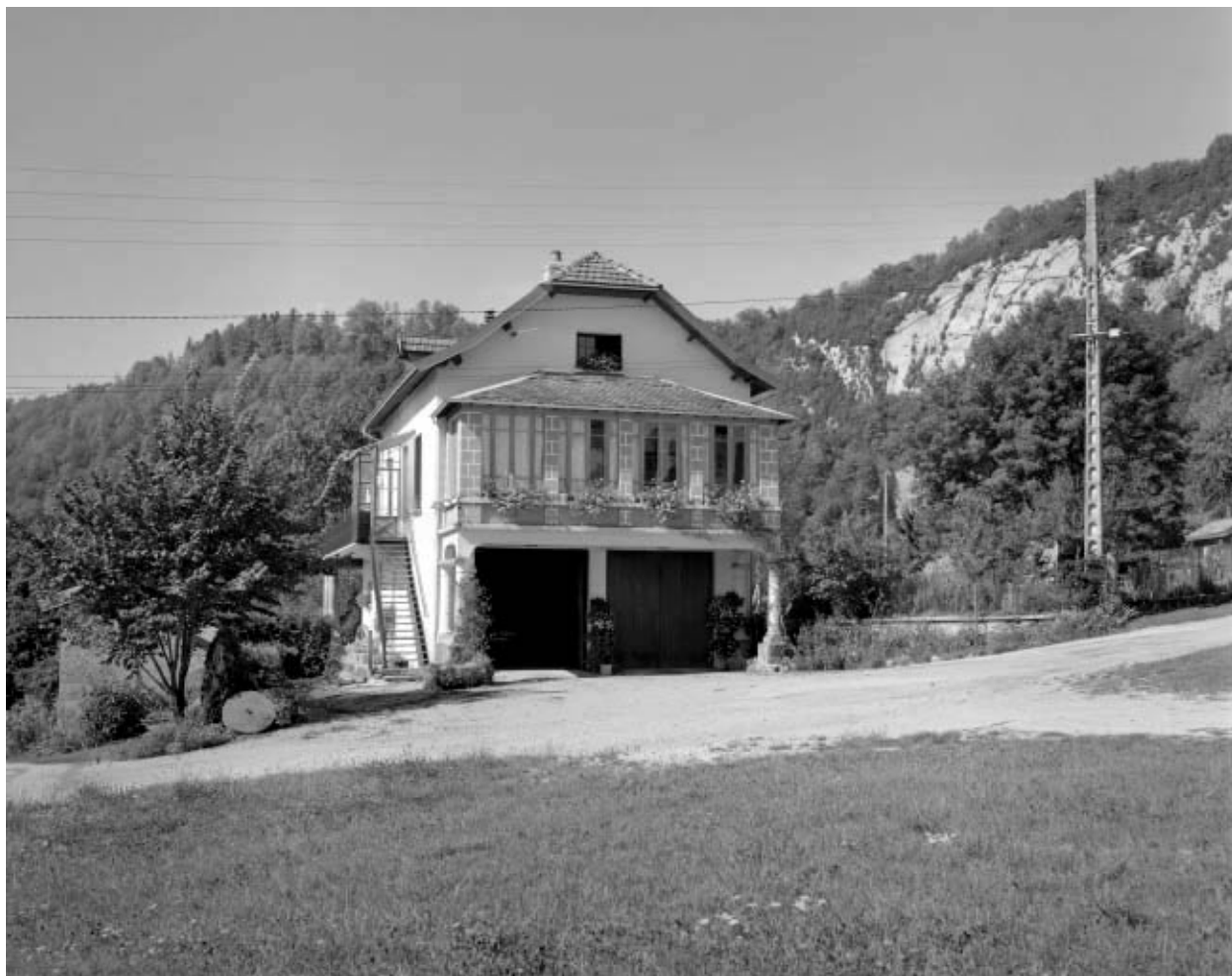
Logement patronal depuis l'est.
