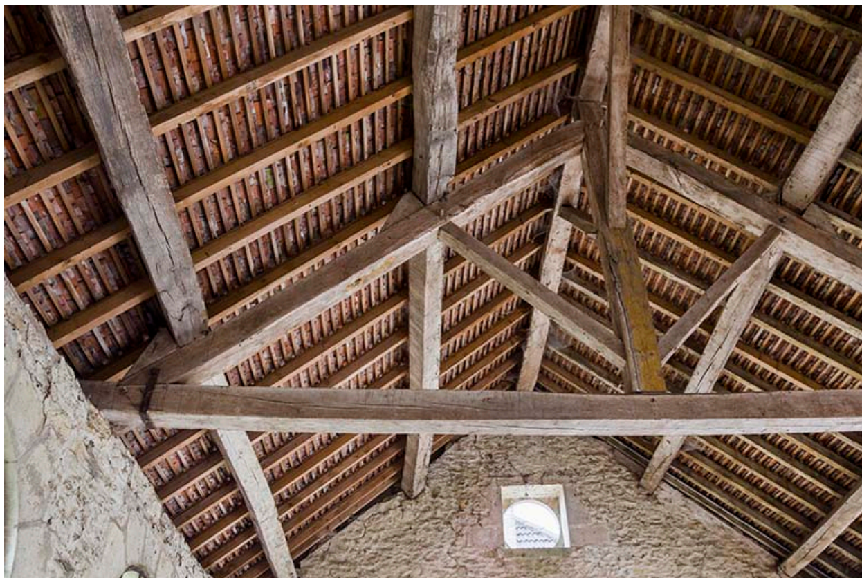
Charpente et oculus.
