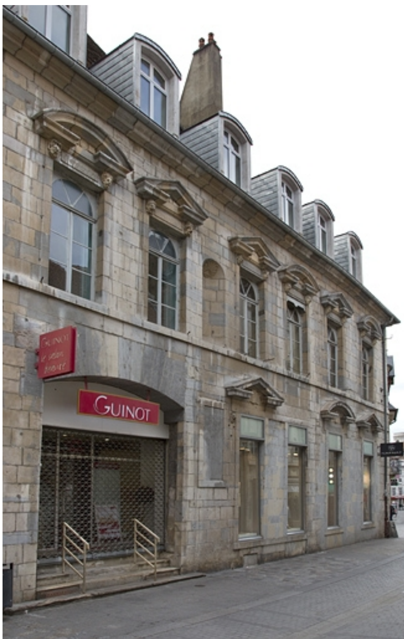
Façade antérieure : détail de la partie droite.
