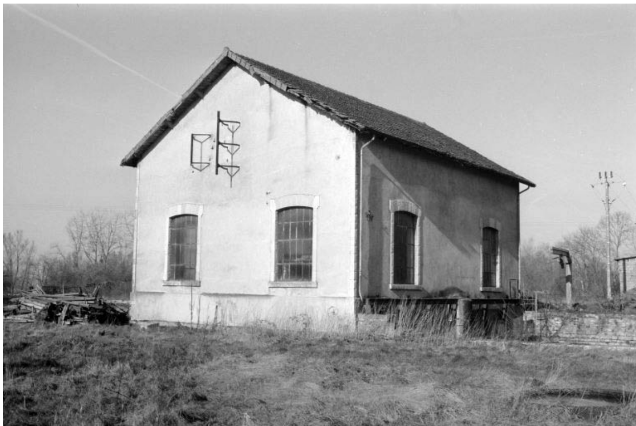
Façades postérieure et latérale gauche de la centrale hydroélectrique (G).
