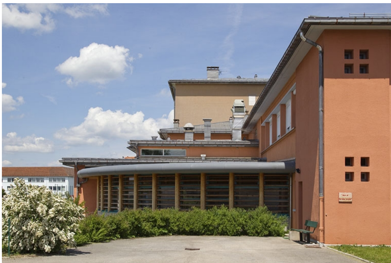
Bâtiment de la restauration : extrémité sud.
