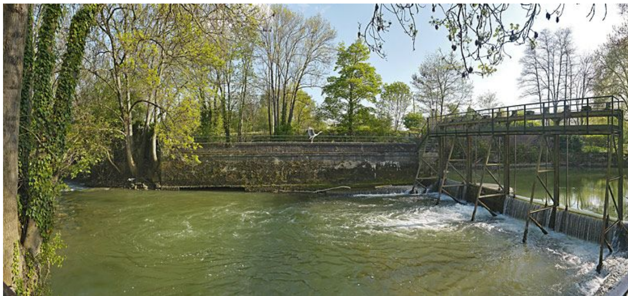
Barrage et vanne.
