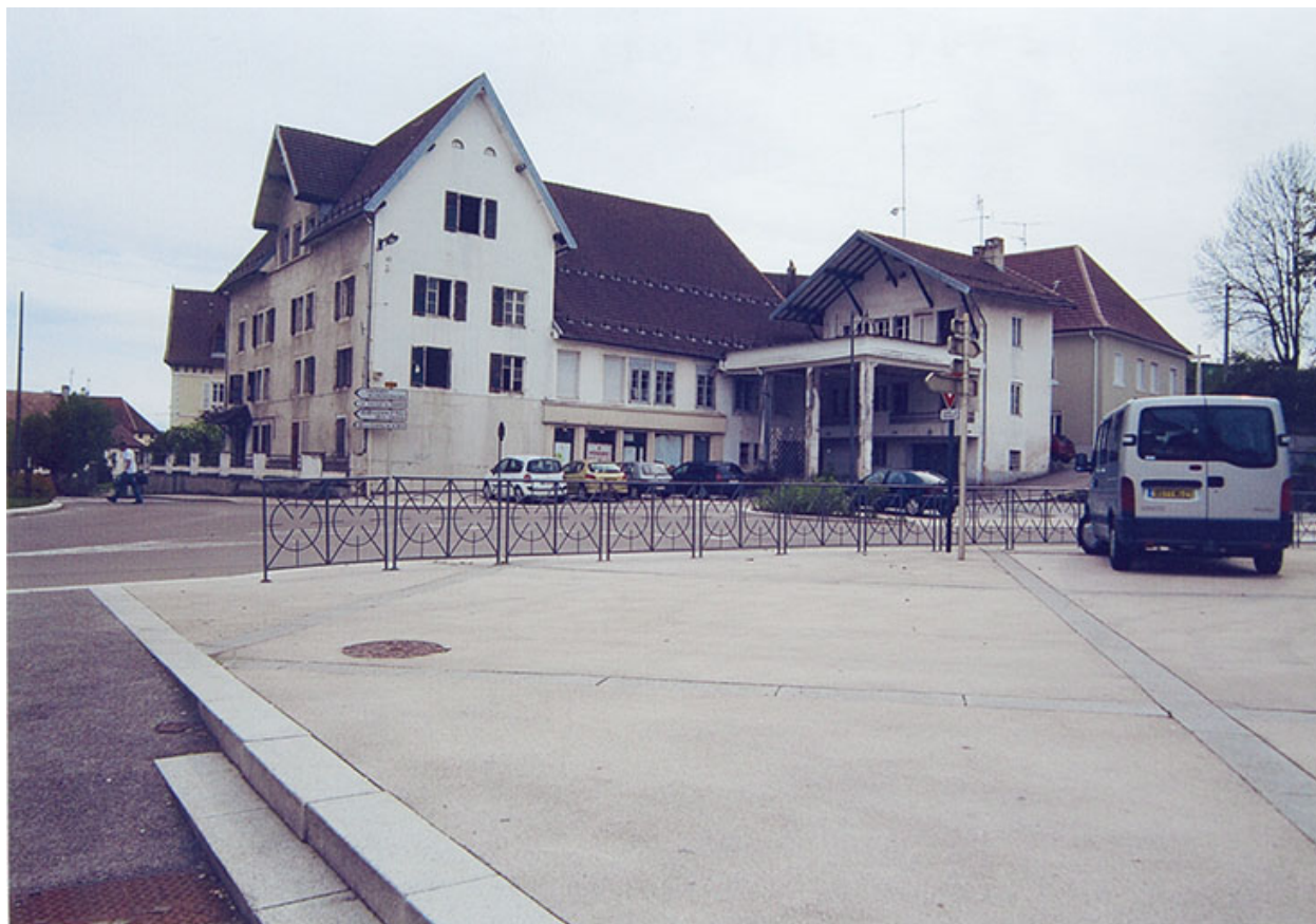
Vue d'ensemble depuis le nord-est, début juin 2012.
