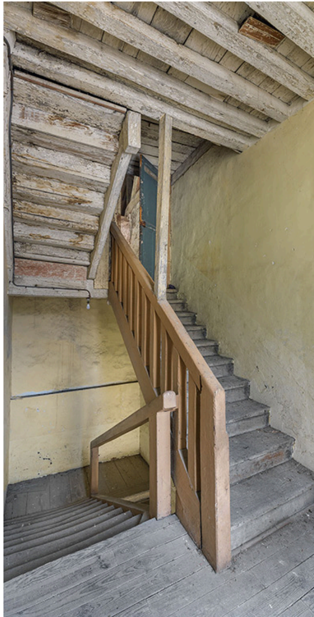
Caserne Vauban : cage d'escalier au 1er étage.
