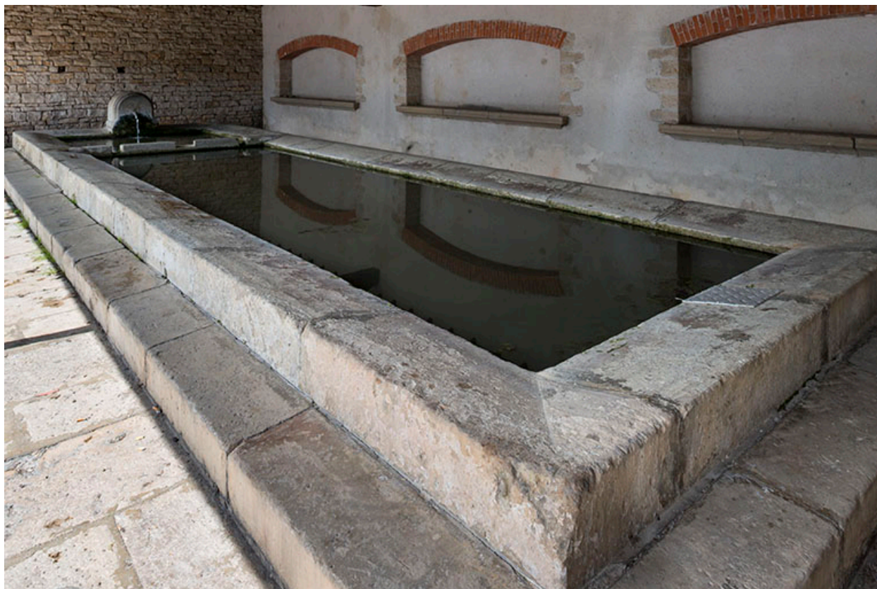
Bassin du lavoir.
