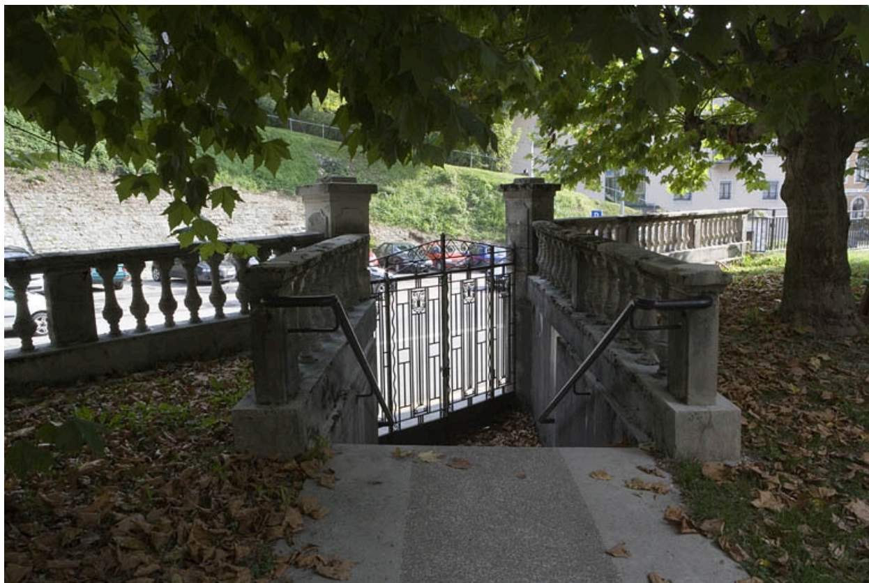
Escalier indépendant, côté jardin.
