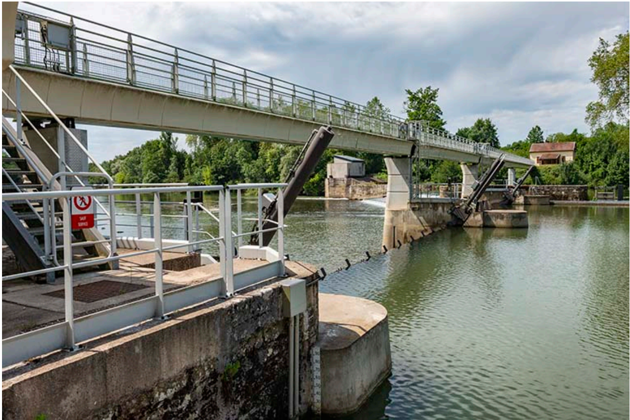
Le barrage à clapets.
