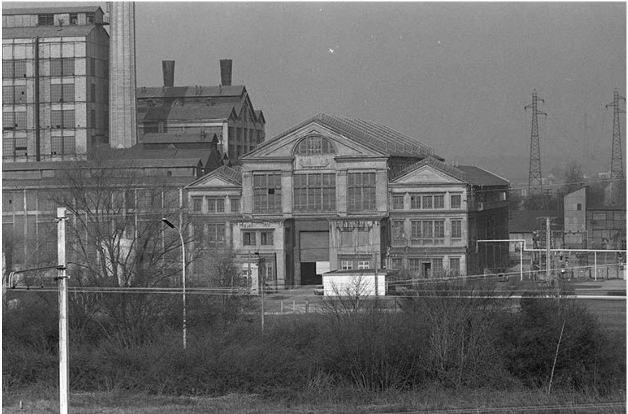
Façade antérieure de la centrale thermique de Lucy II vue de l'est.
