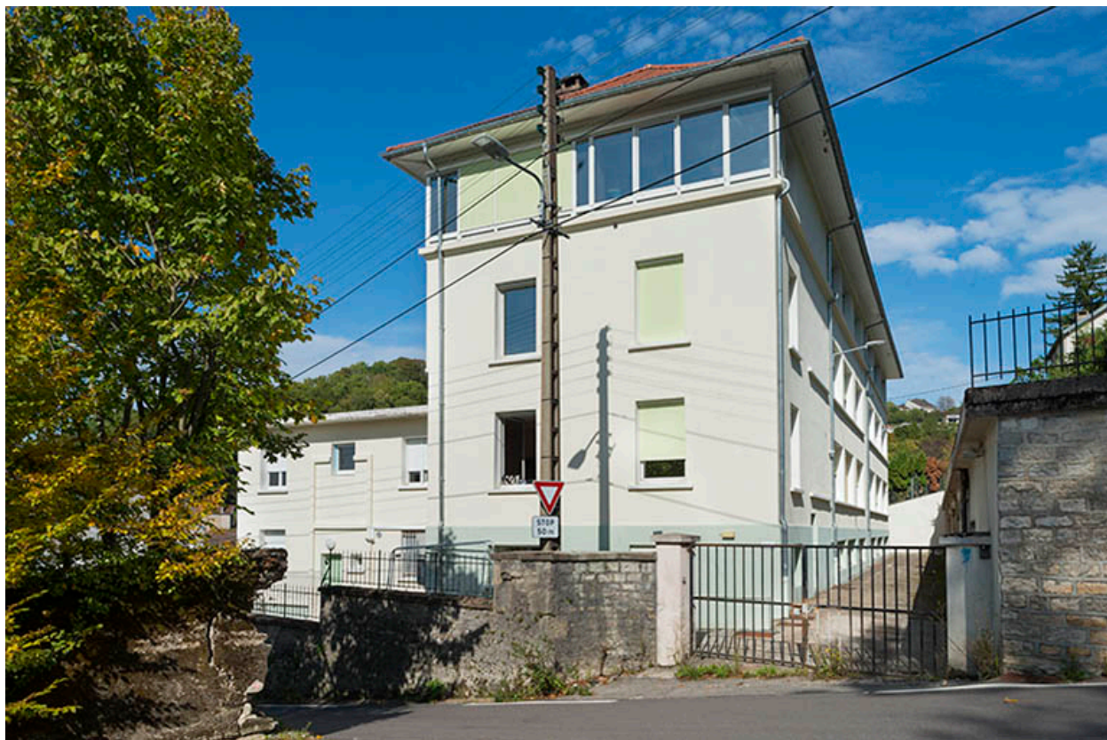
Pignon ouest et façade postérieure.
