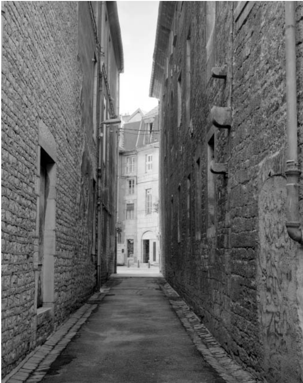
Façade latérale gauche : vue rapprochée.
