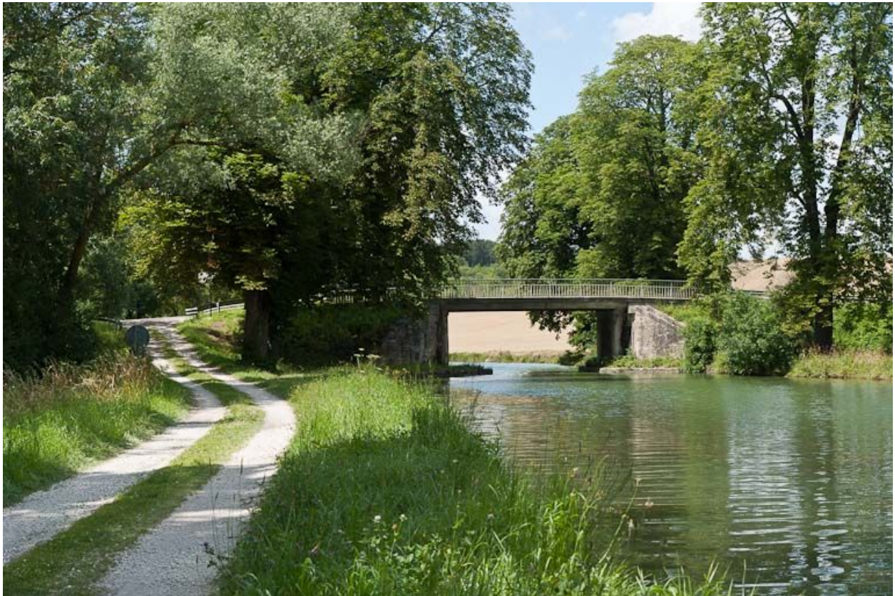
Vue du pont.
