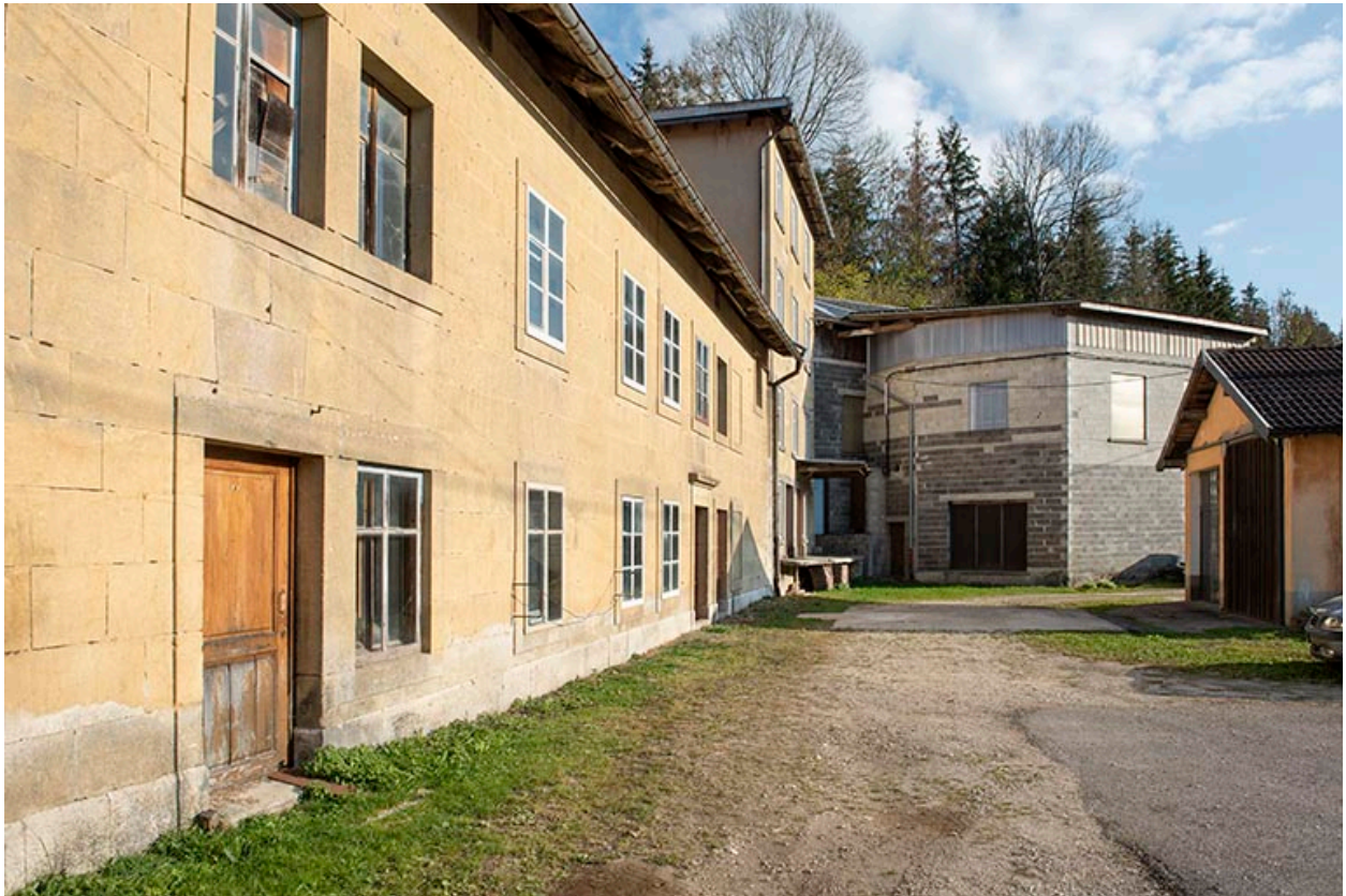
Moulin et minoterie (vus en enfilade), et silos.
