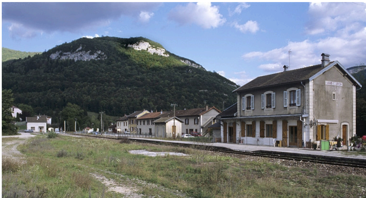
Vue d'ensemble du bâtiment des voyageurs et du " magasin ", depuis le côté La Cluse (ouest).
