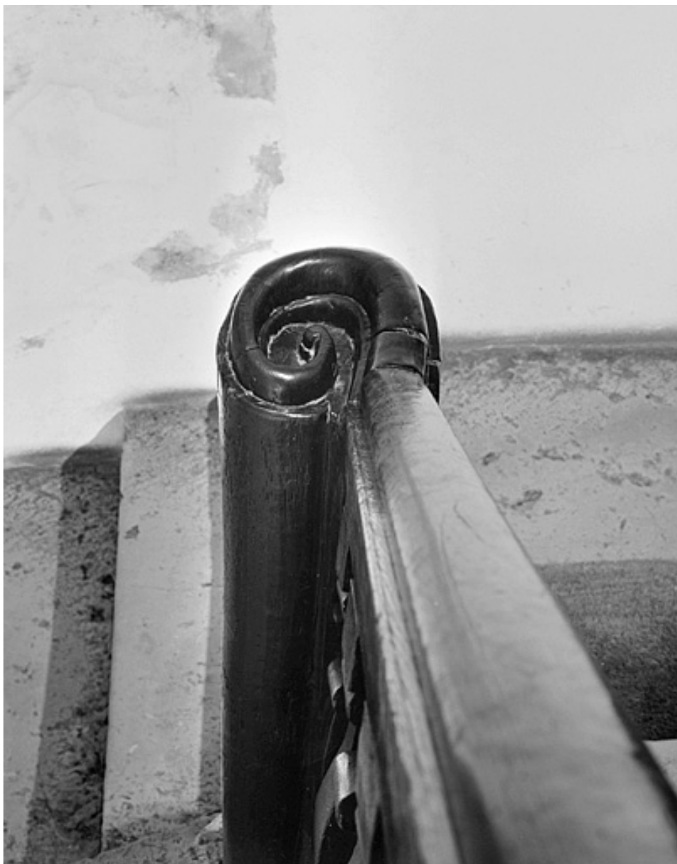
Détail du départ de la rampe d'appui.
