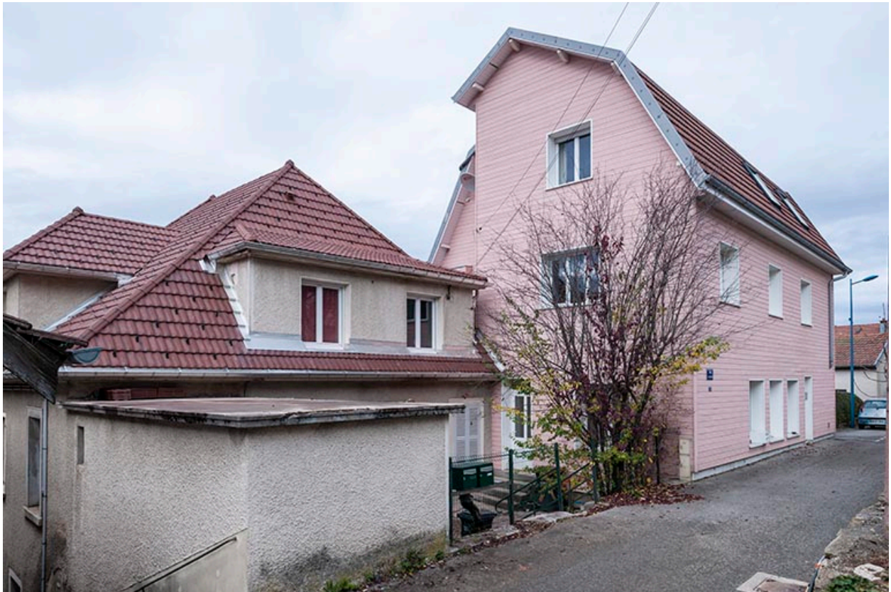
Maison (façade postérieure) et atelier (façades postérieure et latérale droite).
