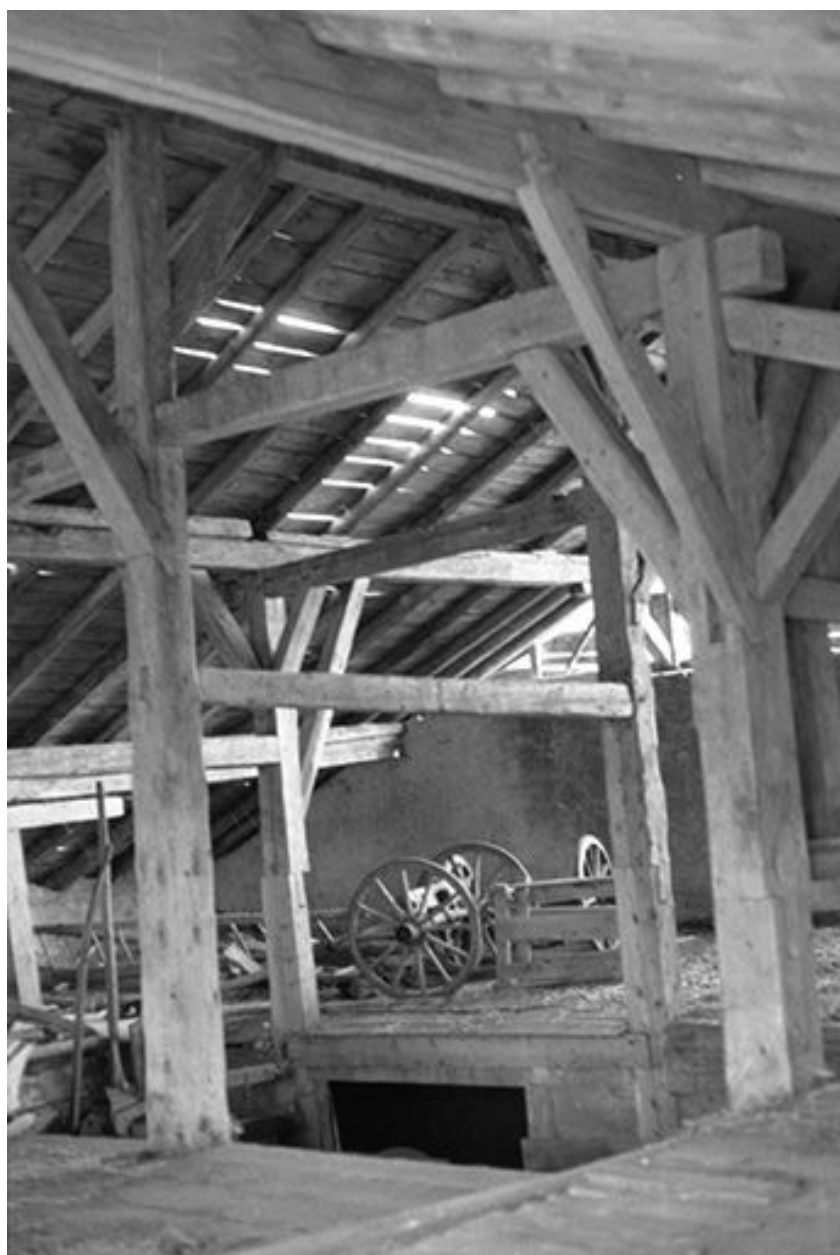
Détail de la charpente.
