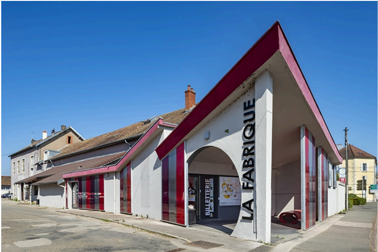
Façade latérale gauche, de trois quarts droite.
