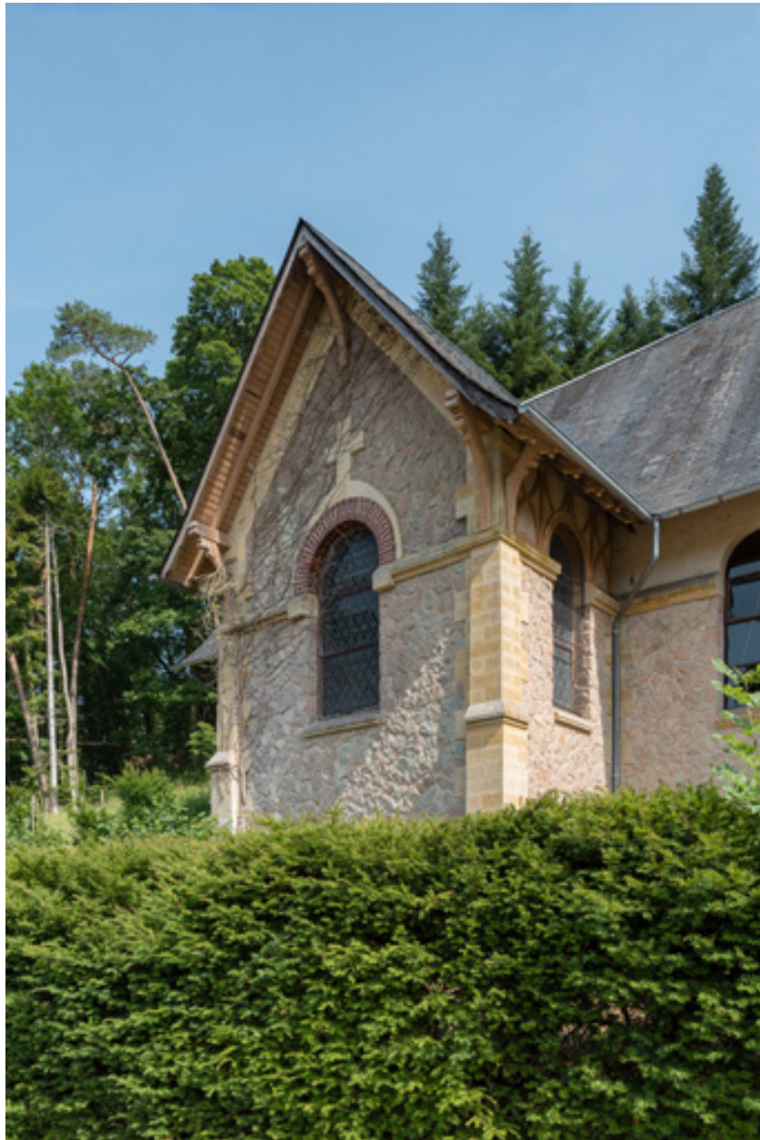
Façade du bras gauche du transept.
