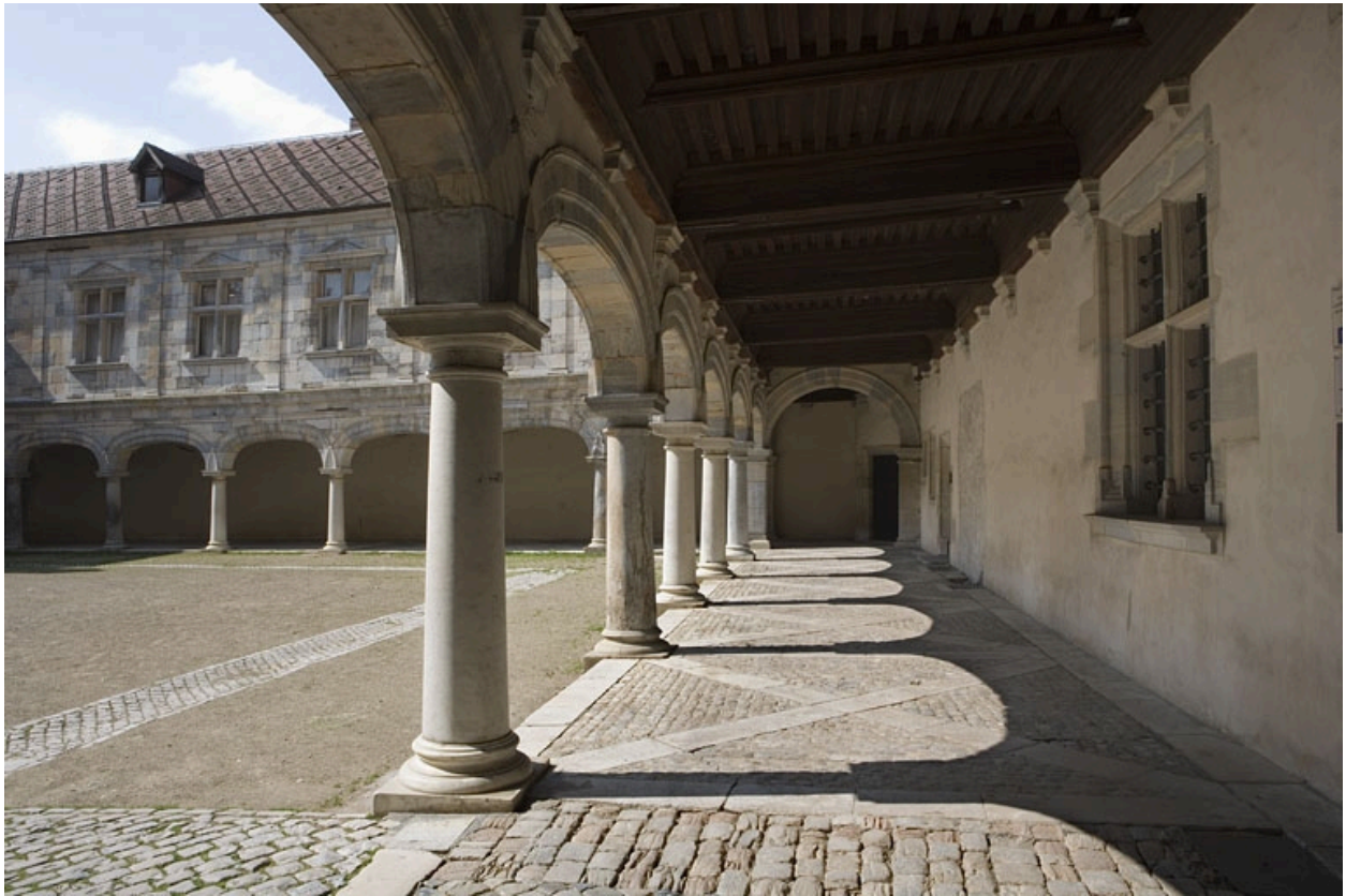
Vue d'ensemble de la galerie nord-est.
