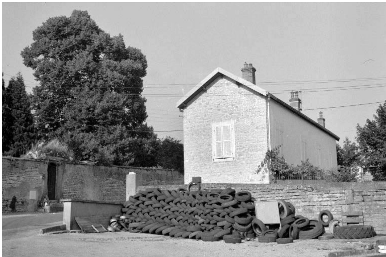
Logement de contremaître.
