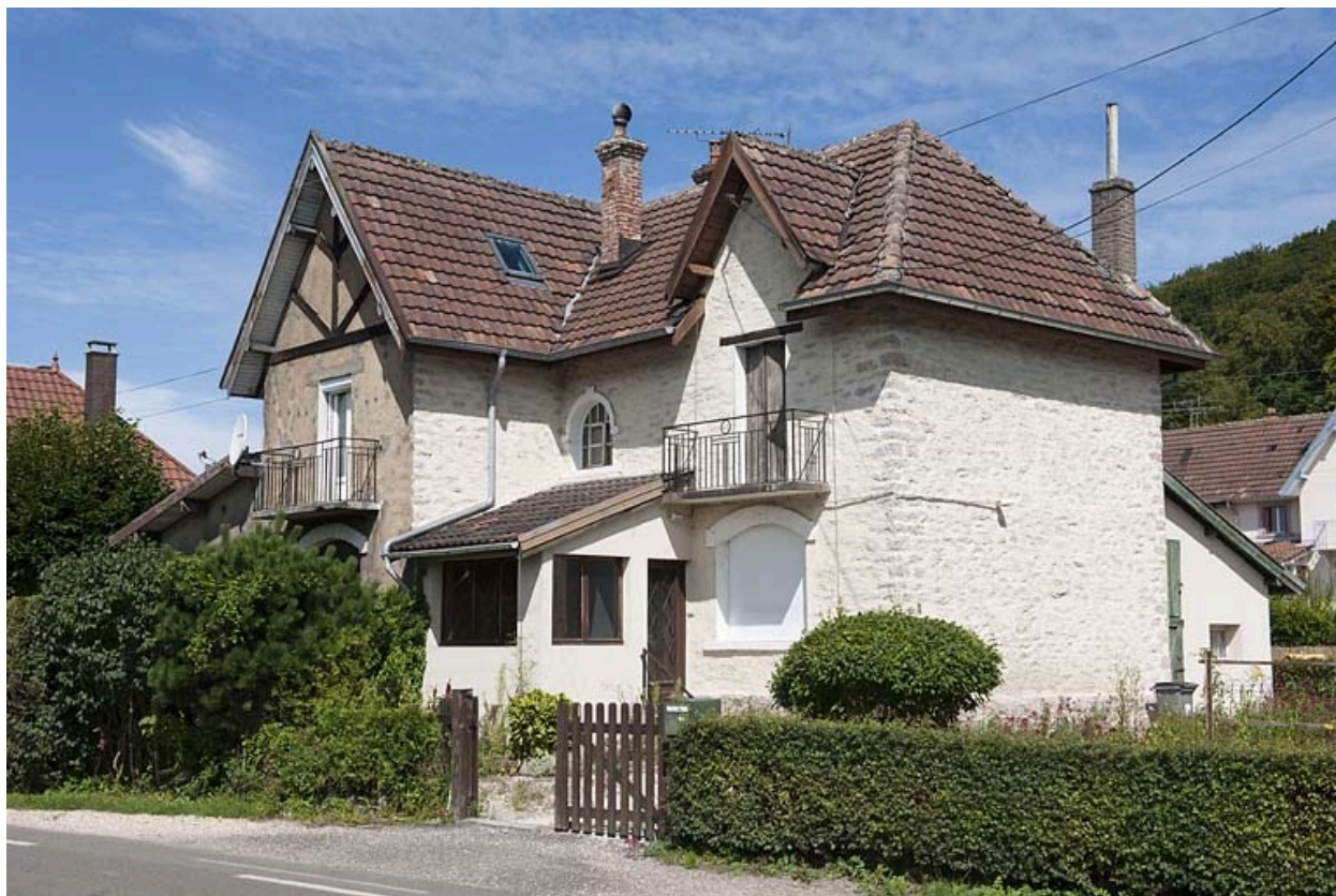
Maison de contremaîtres vue de trois quarts.
