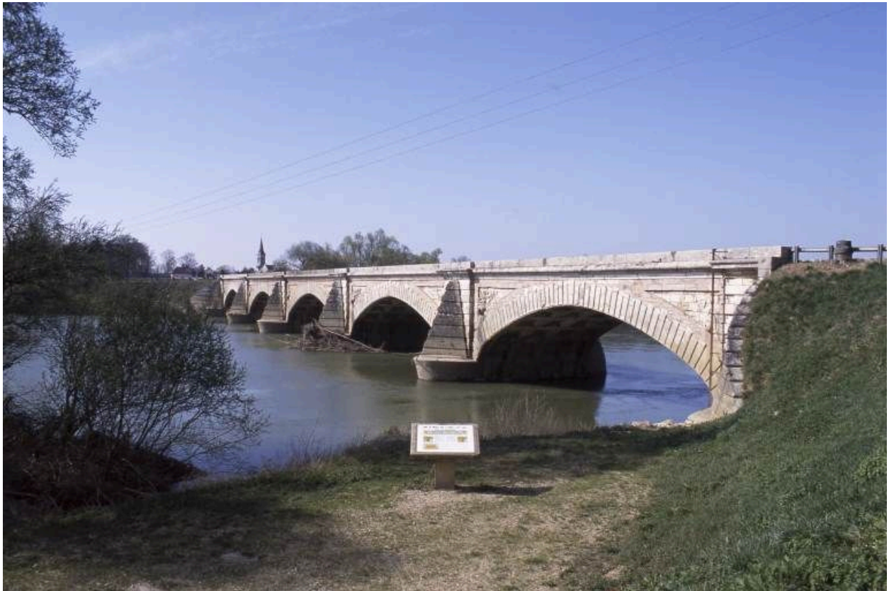
Vue d'ensemble en amont.
