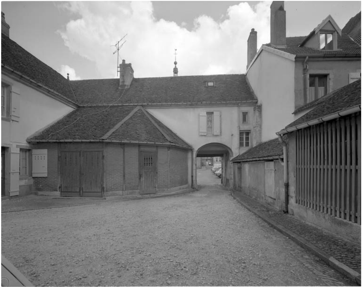
Vue du passage couvert, de face depuis la cour.
