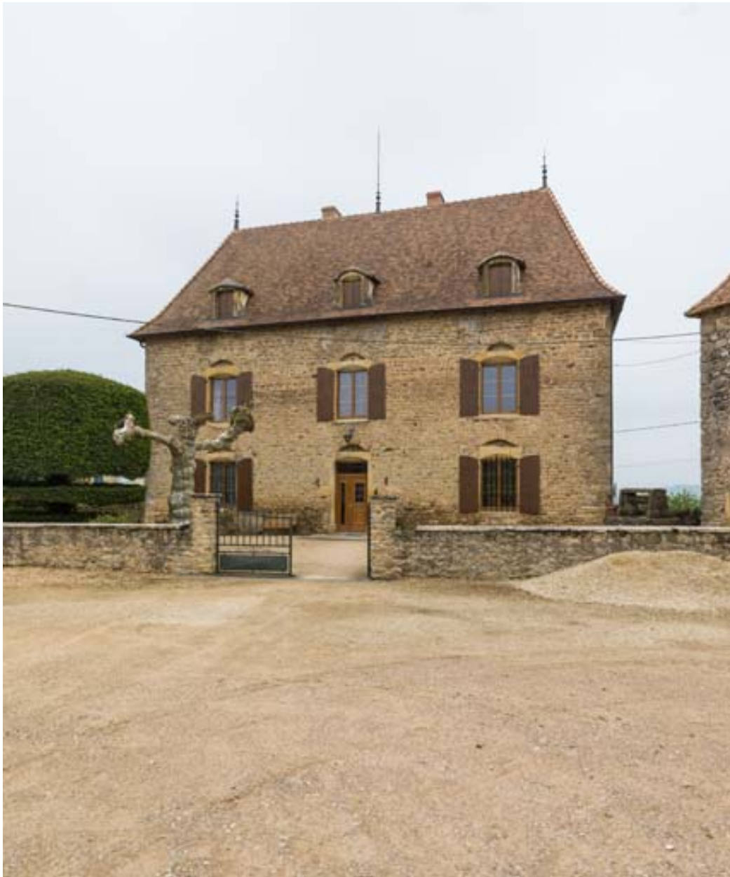
Maison d'habitation. Façade antérieure.
