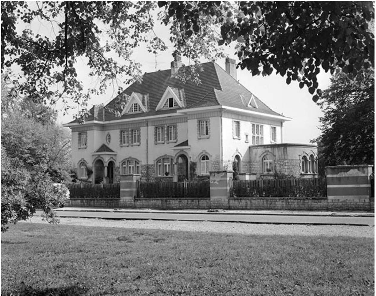
Façade antérieure et face droite de la maison 2, 4 avenue Alfred Solvay.
