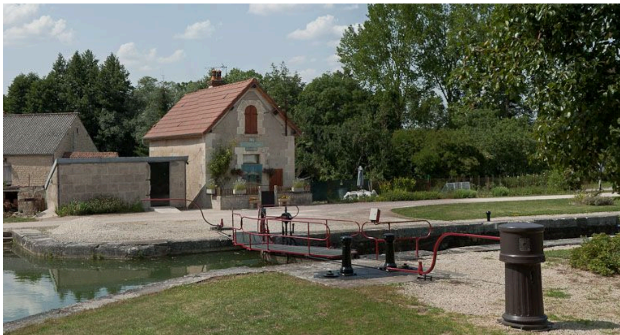
Vue d'ensemble du site d'écluse.
