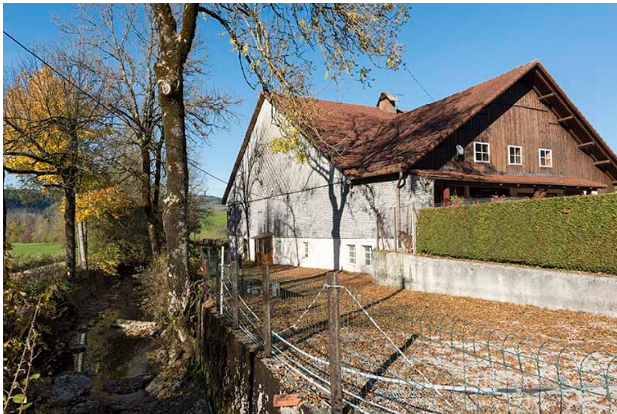
Façades antérieure et latérale gauche (ouest).
