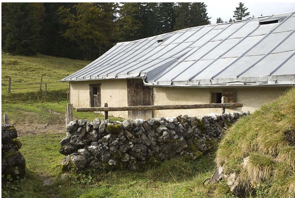
Muret de protection de la citerne.
