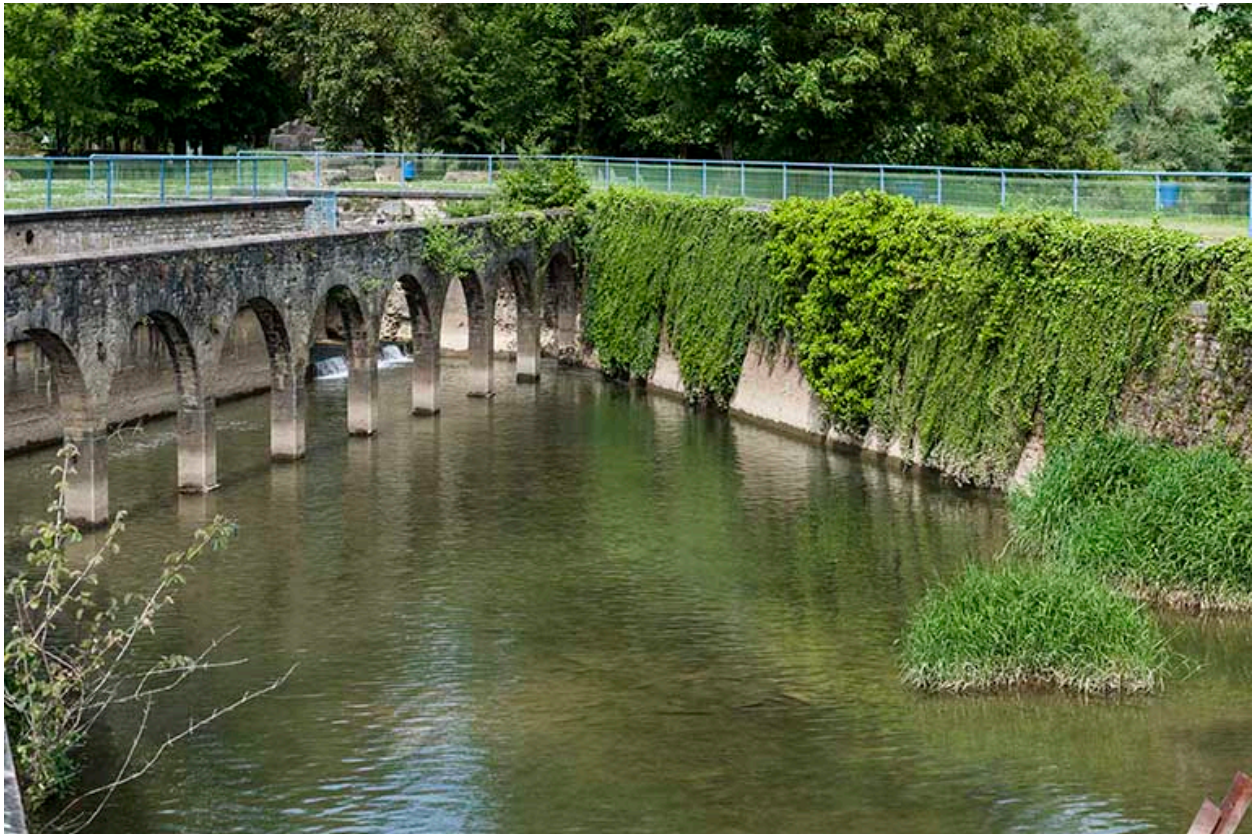
L'ancien canal de fuite.
