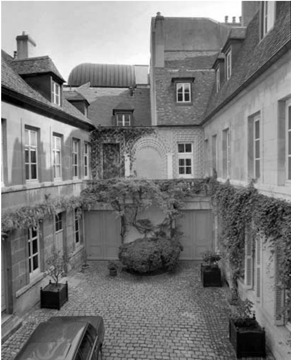
Vue d'ensemble de la cour depuis le logis principal.
