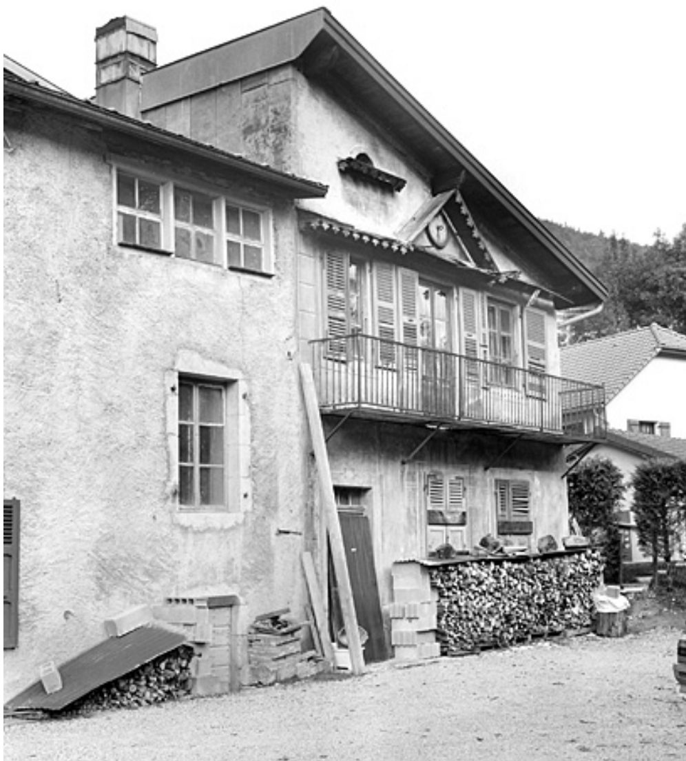
Elévation antérieure du corps de bâtiment nord.
