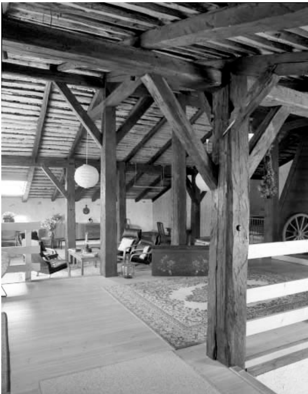
Les Moussières, ferme : grange haute et charpente sur poteaux.
