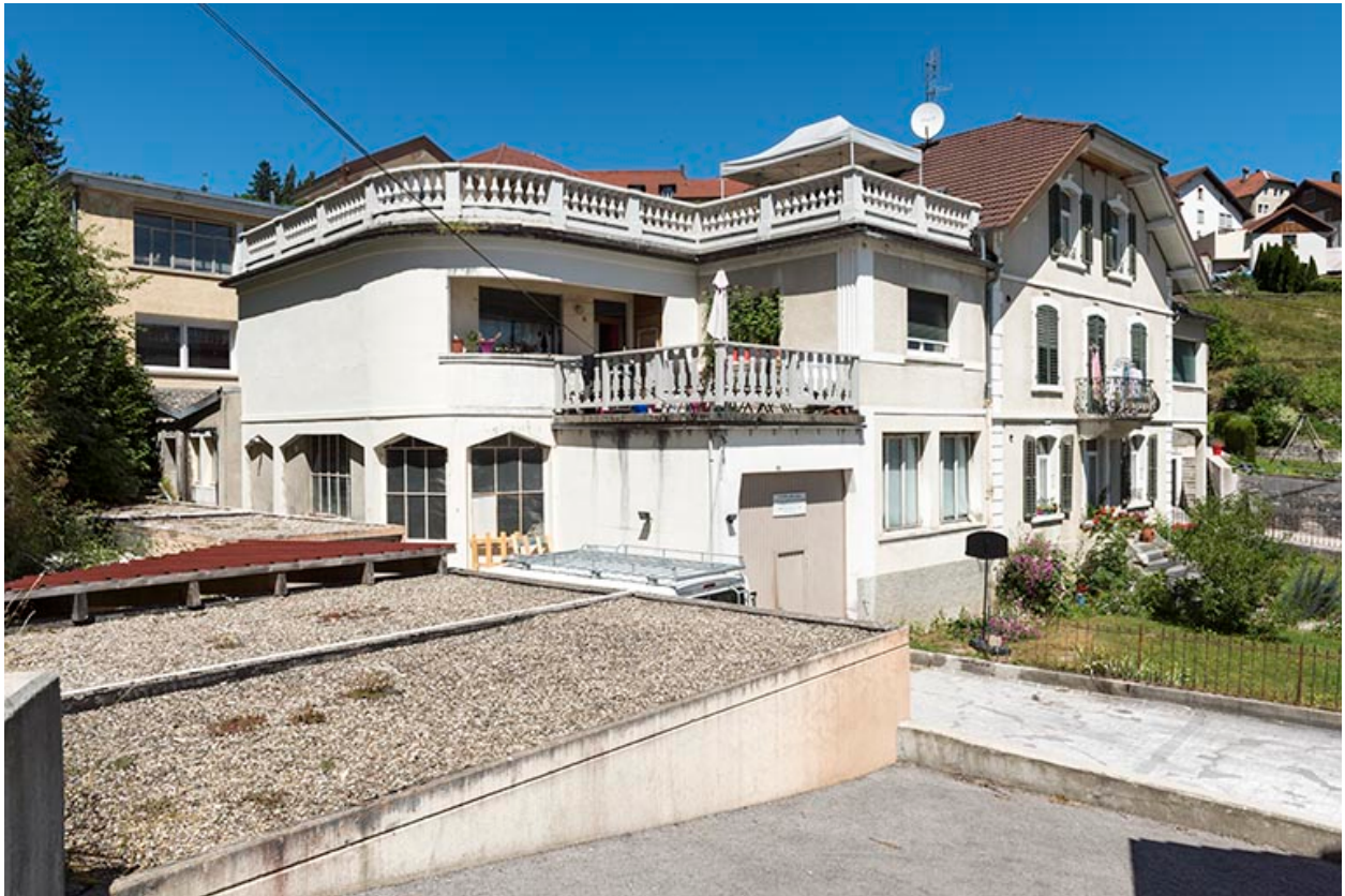
Maison : façades antérieure et latérale gauche.
