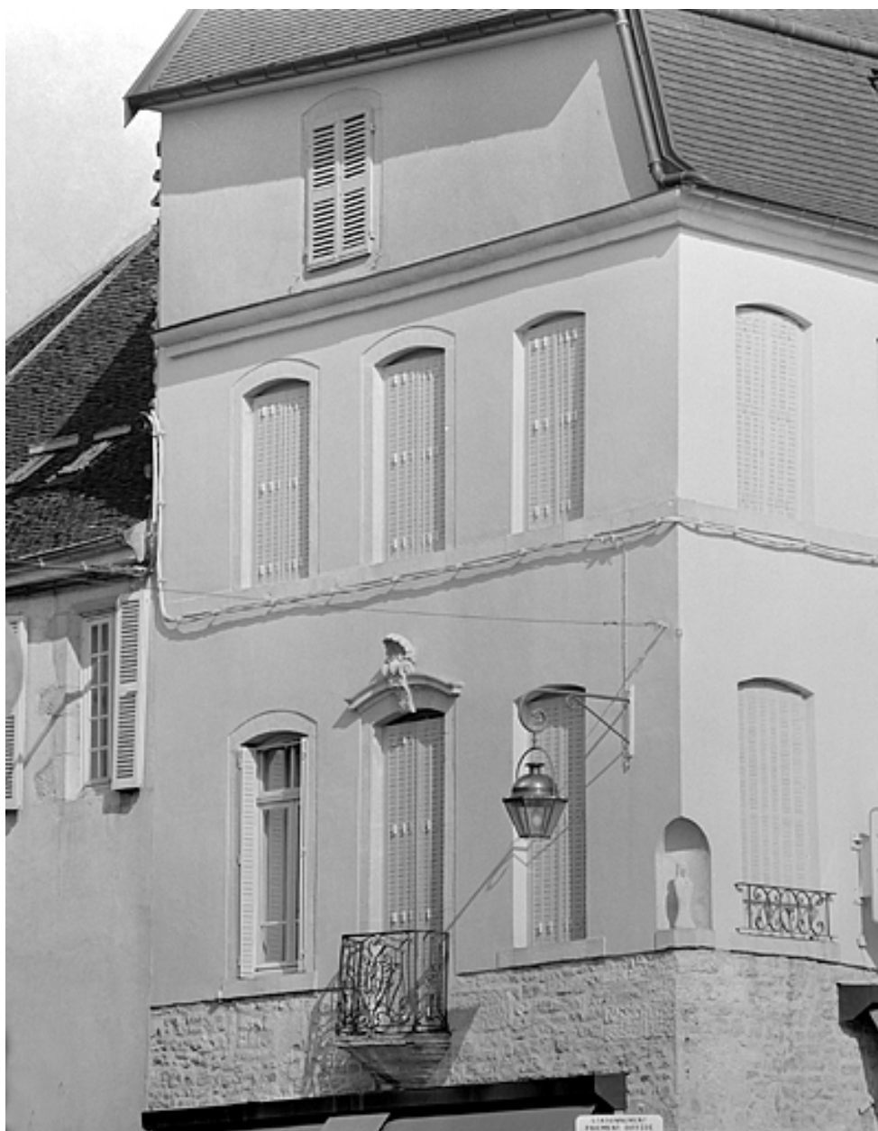
Elévation sur la rue du Commerce.
