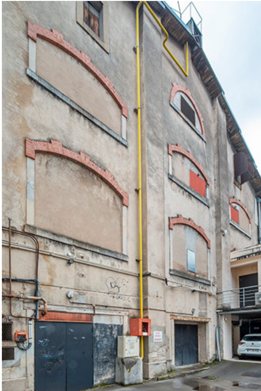
Halle : façade postérieure depuis la cour.
