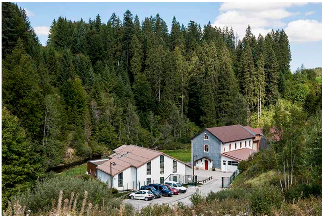
Centrale du Fourpéret, Labergement-Sainte-Marie.
