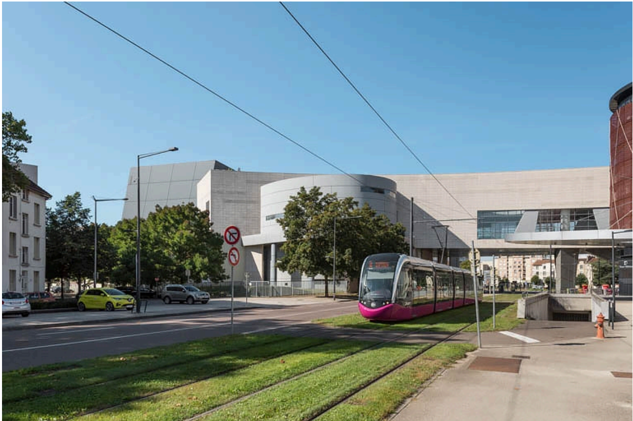
Vue d'ensemble depuis l'est, avec tramway.
