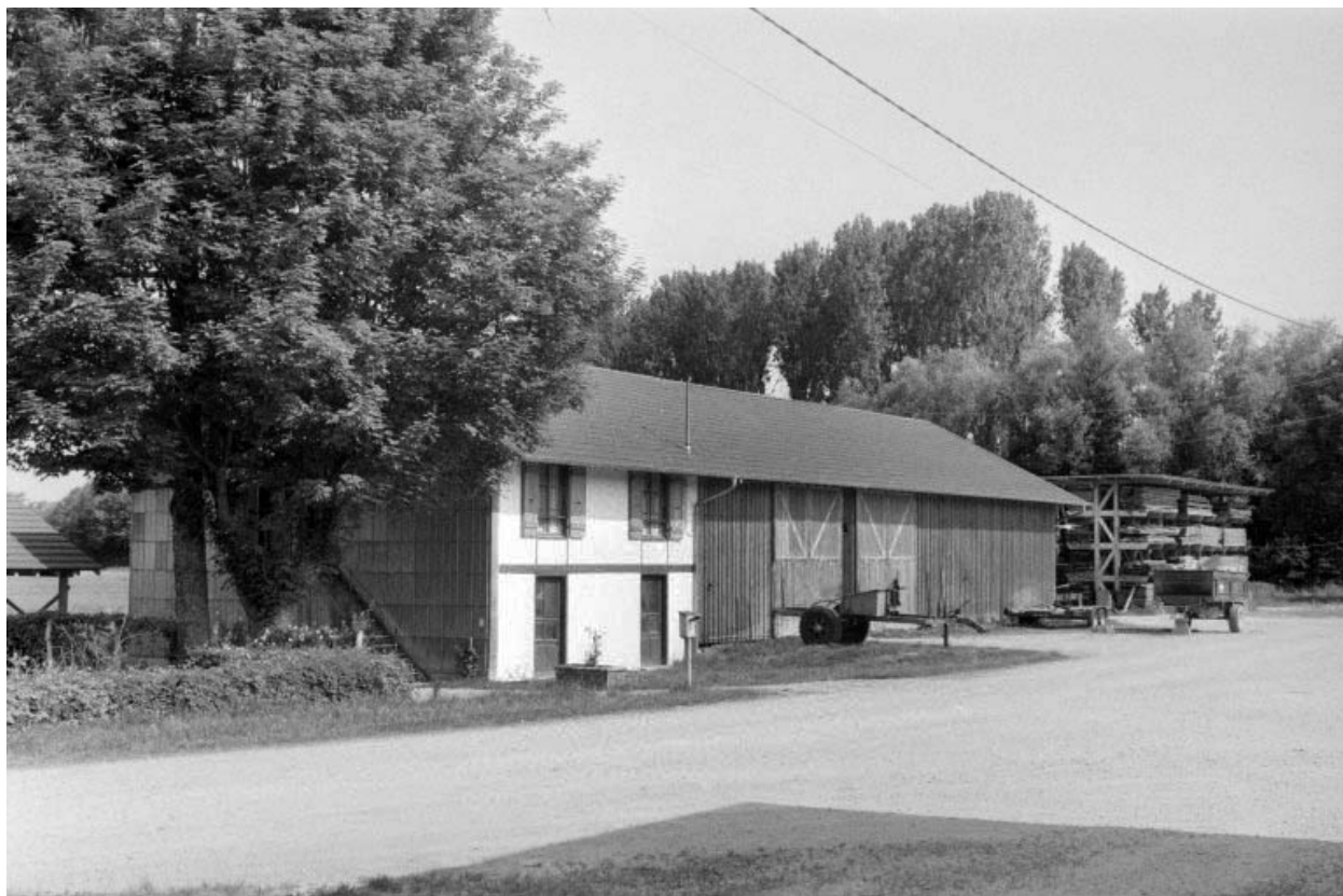
Magasin industriel (M) et logement d'ouvriers (N).
