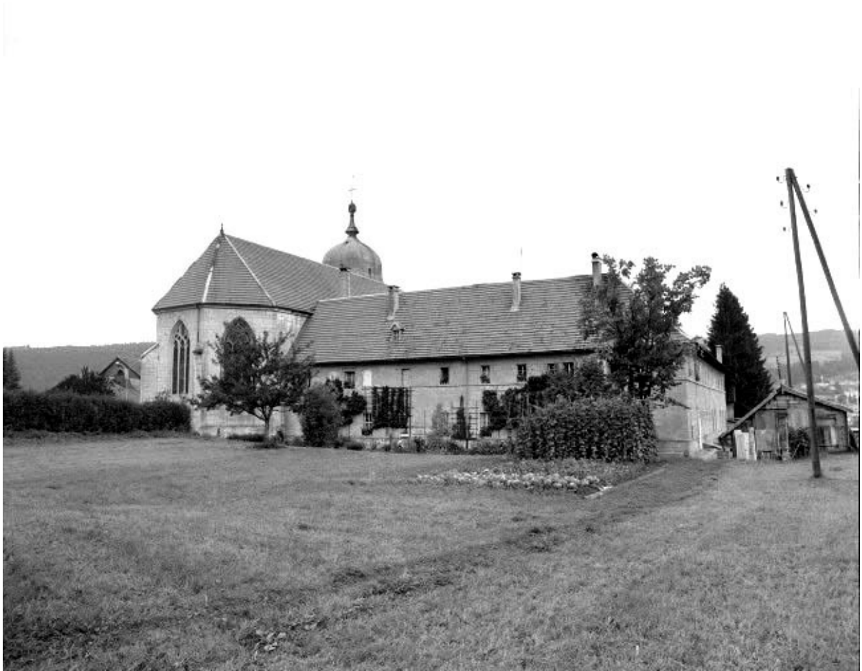
Extérieur : façade est.
