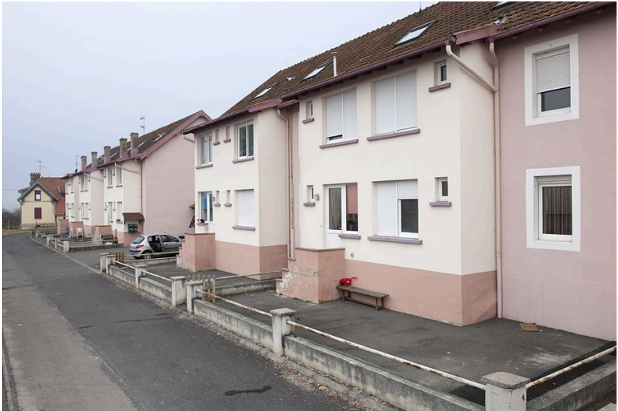
Immeubles d'habitation vus depuis l'est.
