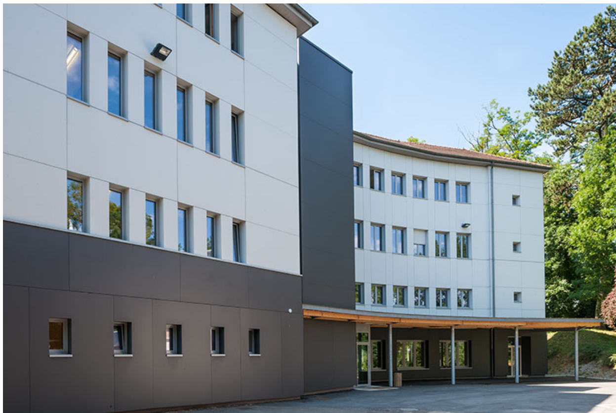
Externat : aile ouest , façade antérieure.
