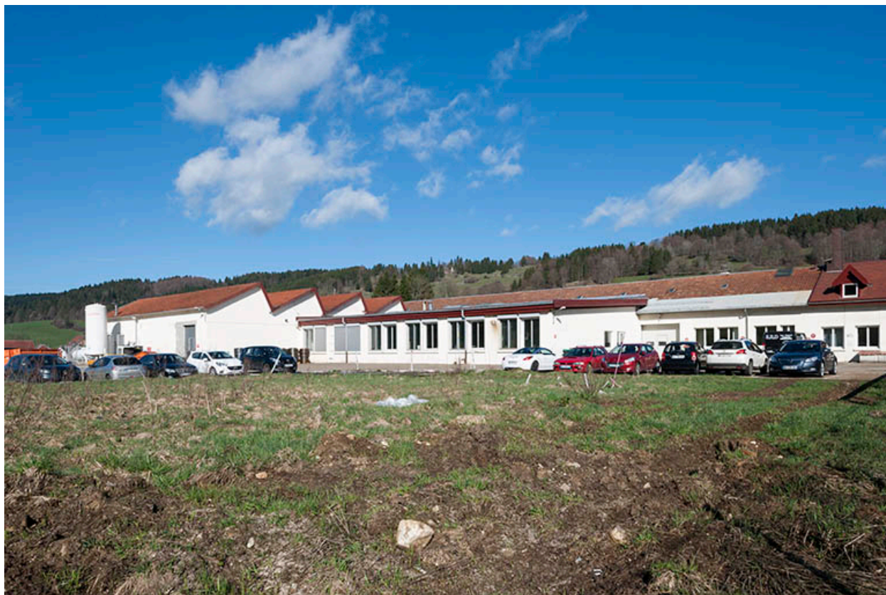
Vue depuis le sud-est.
