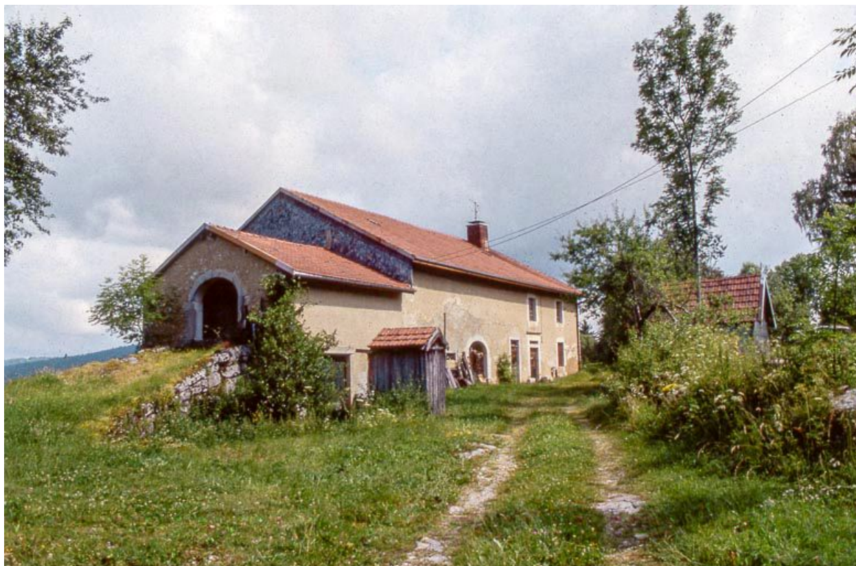
Vue éloignée de la façade antérieure.
