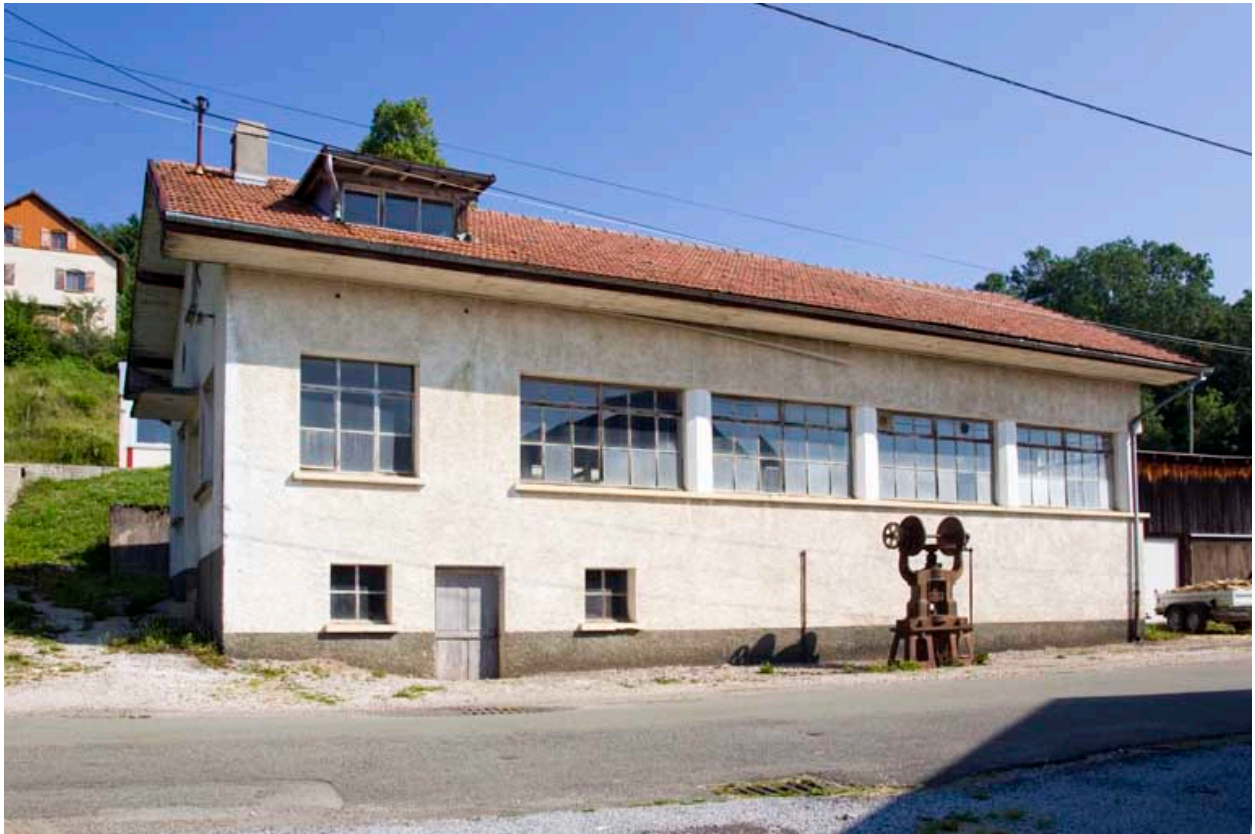
Atelier d'origine : façade antérieure.
